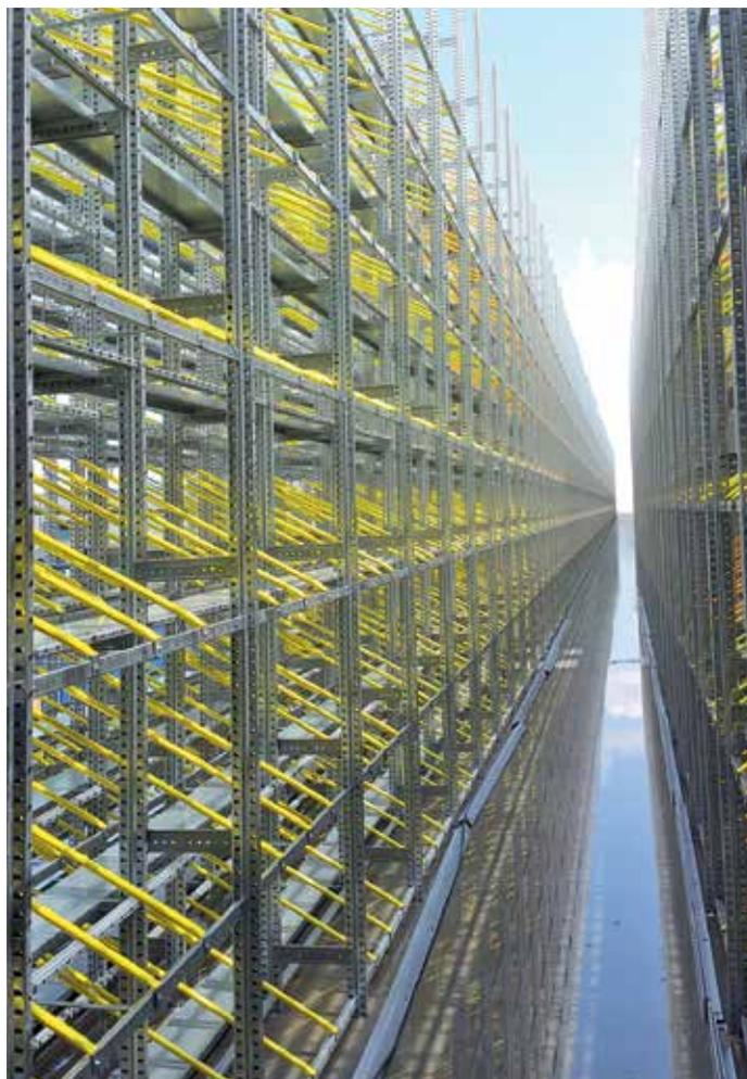
Blick in das riesige Räderlager – in dieser Bauphase ist noch kein Dach montiert. Gut erkennbar sind die gelb ummantelten Fachteiler, die auch dem Felgenschutz dienen.
