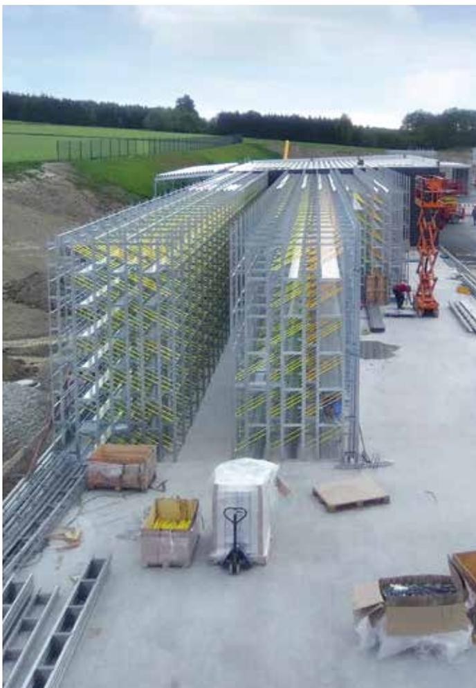
Reifenregale für jedes Lagervolumen – als Cover-Halle stets erweiterbar, wächst daher bedarfsgerecht mit. Hier der Grundaufbau der Regale, die später verkleidet werden.
